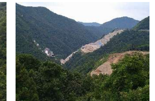
ダム本体・法面对策 全景
