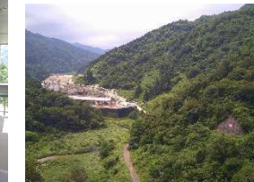
骨材製造設備
