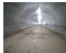
利賀トンネル内
